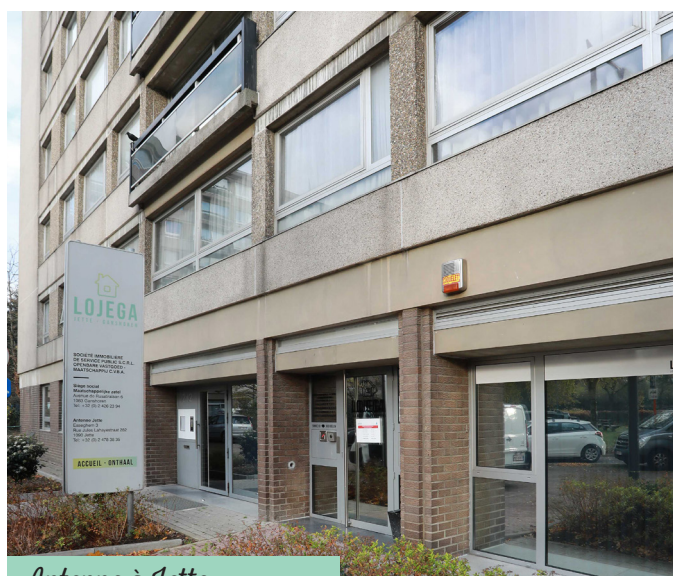
Antenne à Jette
