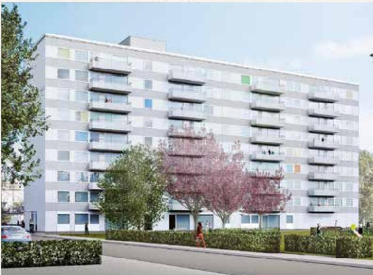
Au niveau de l'aspect esthétique extérieur, les parements en béton existants seront recouverts de métal blanc. De nouveaux châssis en aluminium seront également installés pour leur résistance aux intempéries et à l'usure.
